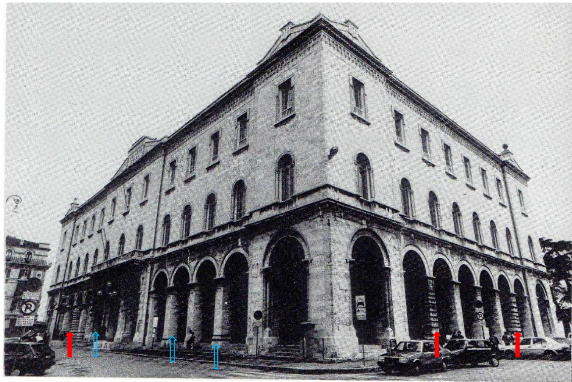
Palazzo della Provincia di Perugia. Veduta d'insieme con alcuni dei pilastri cerchiati contro lo schiacciamento cubico.
