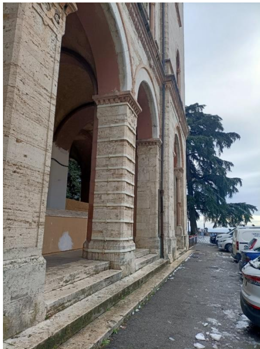
Palazzo della Provincia di Perugia. Cerchiatura di un pilastro di sezione quadra ta, contro lo schiacciamento.
