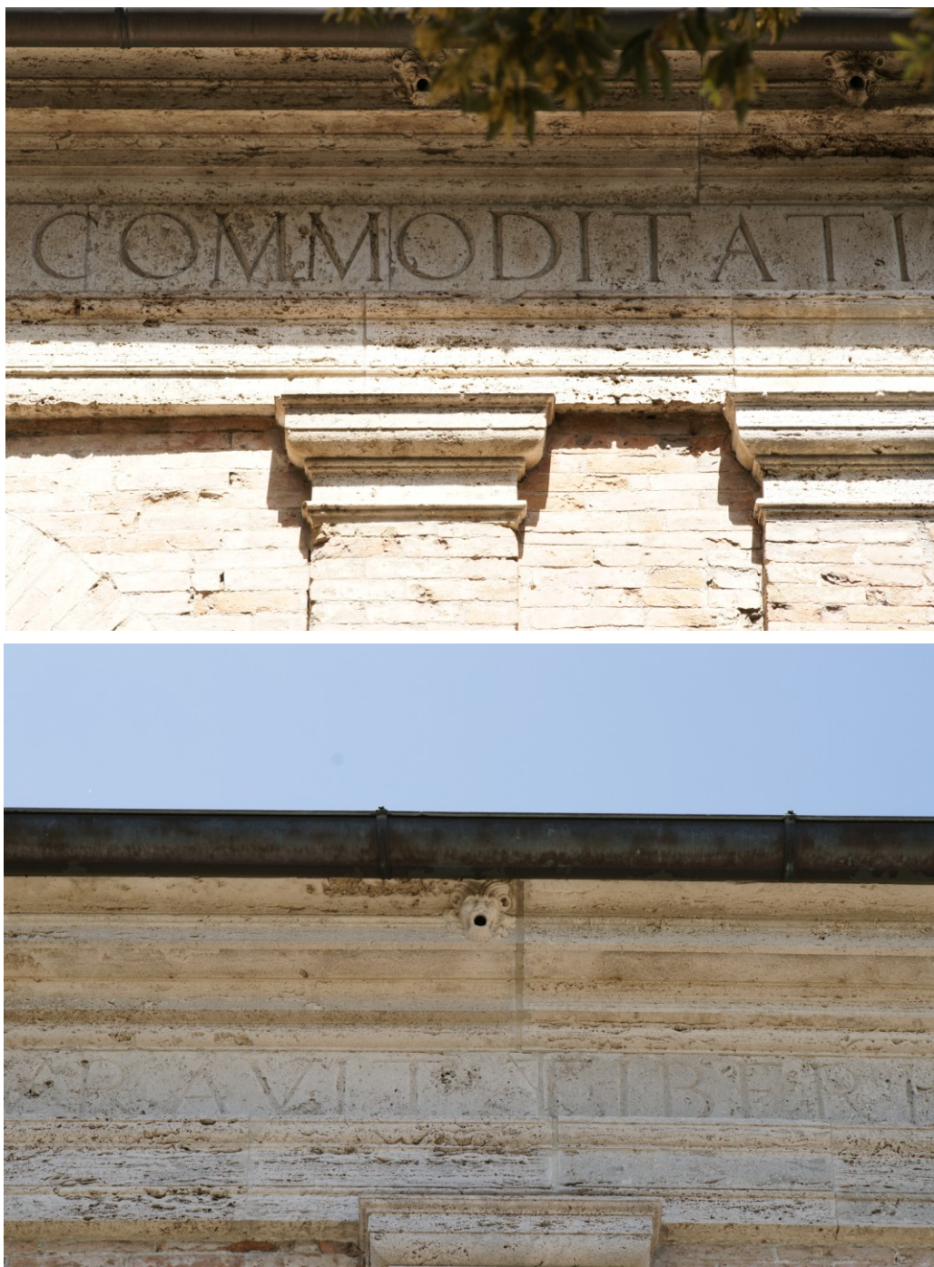
Particolare della trabeazione (foto L. Sportolari 2012)
